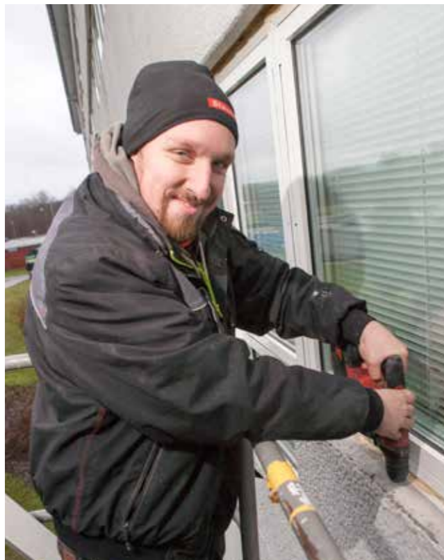
Fönstermonteringen på Saffransgatan utfördes av Bygg & Miljöteknik.
