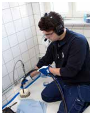
Vid relining kan hyresgästerna bo kvar i sin lägenhet.
