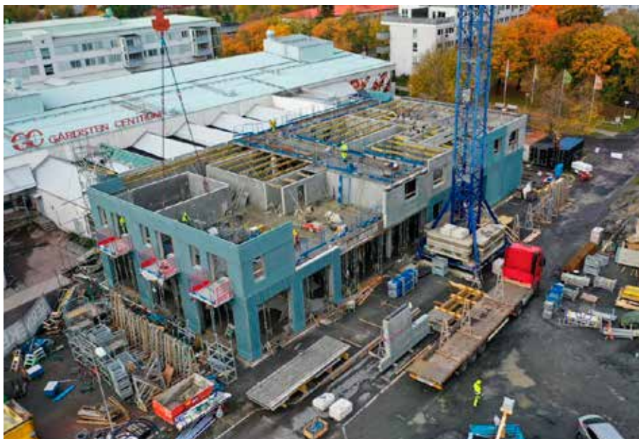
Pågående byggnation i Gårdsten Centrum
