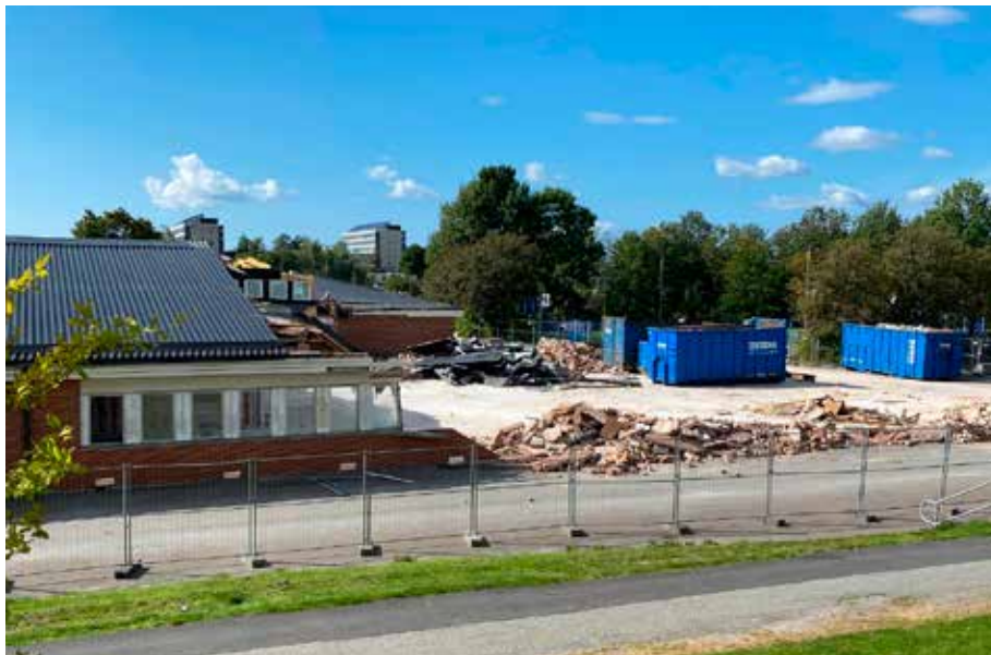
Rivningen av den befintliga Gårdstensskolan har kommit en bit på väg.
