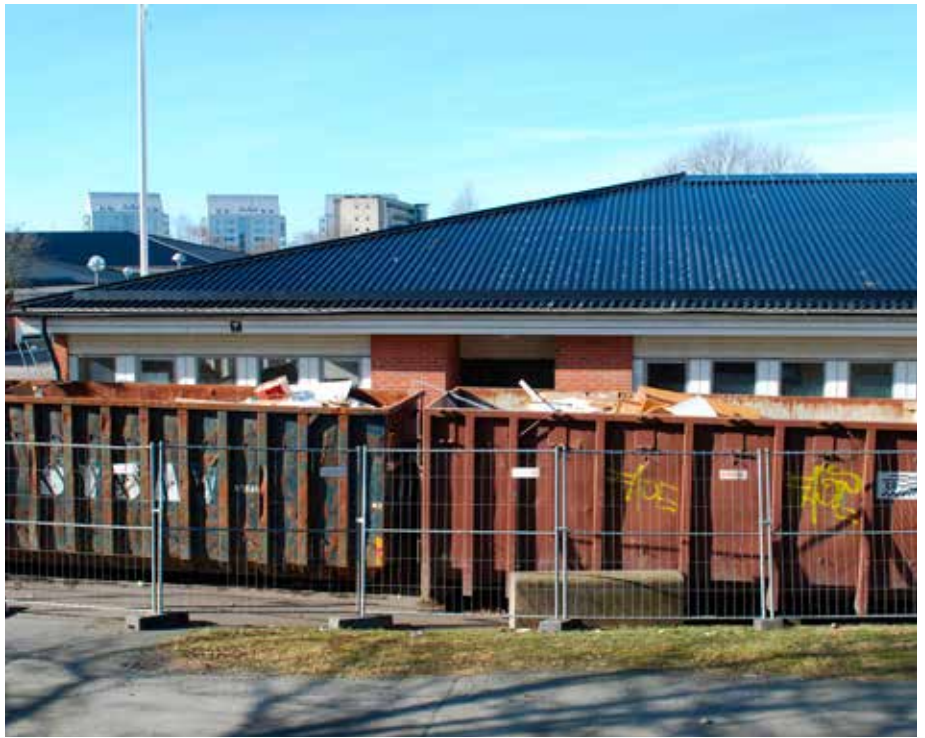
Gårdstensskolan under rivning
