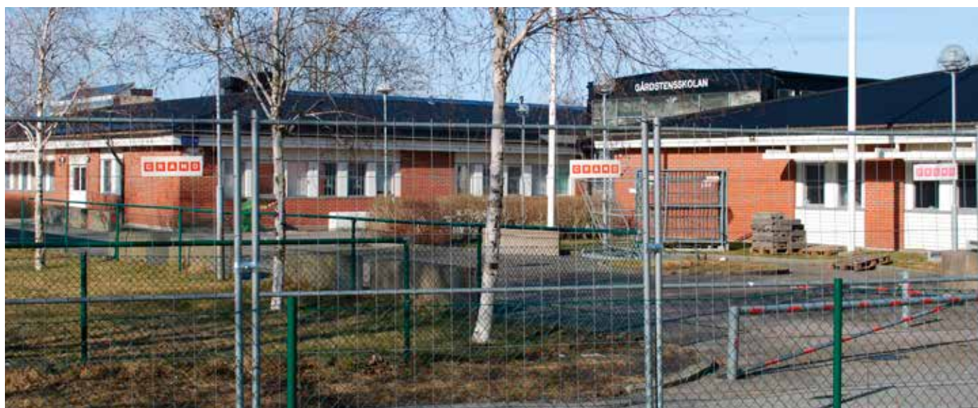
Gårdstensskolan under rivning
