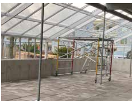
Växthuset på Oxelgården under byggnationen.
