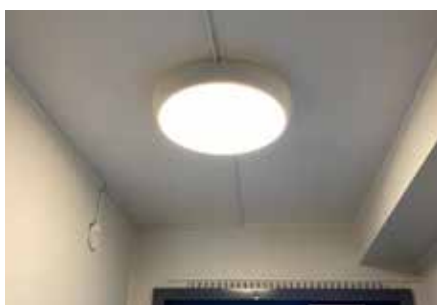
LED-belysning uppsatt i trapphusen på Peppar och Kanelgatan
