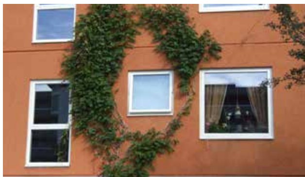
Fönsterbyten i västra Gårdsten, ett mångårigt projekt. Foto: Gårdstensbostäder
