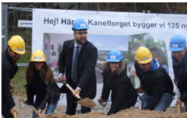
Bostadsministern Mehmet Kaplan, ungdomar och representanter från byggföretagen tar första spadtaget på Nya Kryddhyllan.
